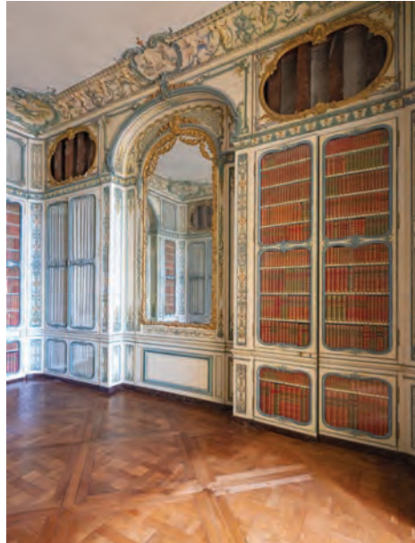
Bibliothèque du Dauphin avant restauration, 2020.
